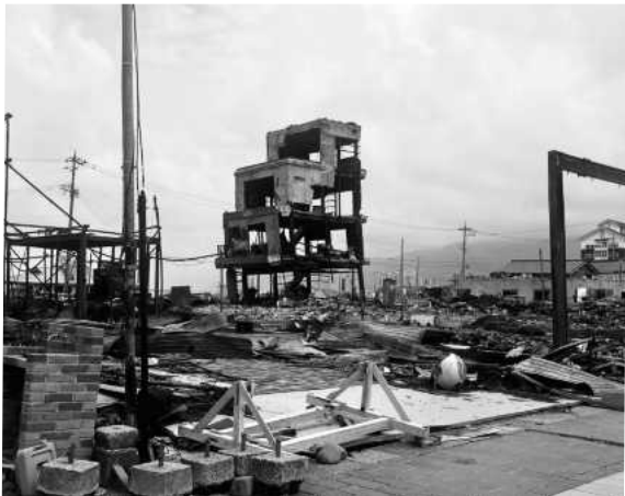
震災と火災の惨状がまだそのまま残る輪島市
